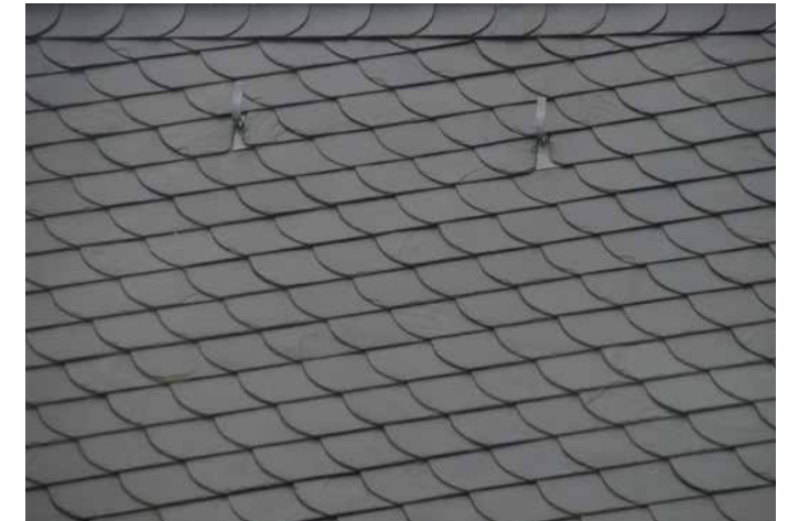
Ein Schieferdach erlaubt eine Vielzahl verschiedener Eindeckungsarten. Der Werkstoff ist natürlich, robust und mit einer Nutzungszeit von über 80 Jahren sehr langlebig.
